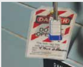
Sperren und kennzeichnen
